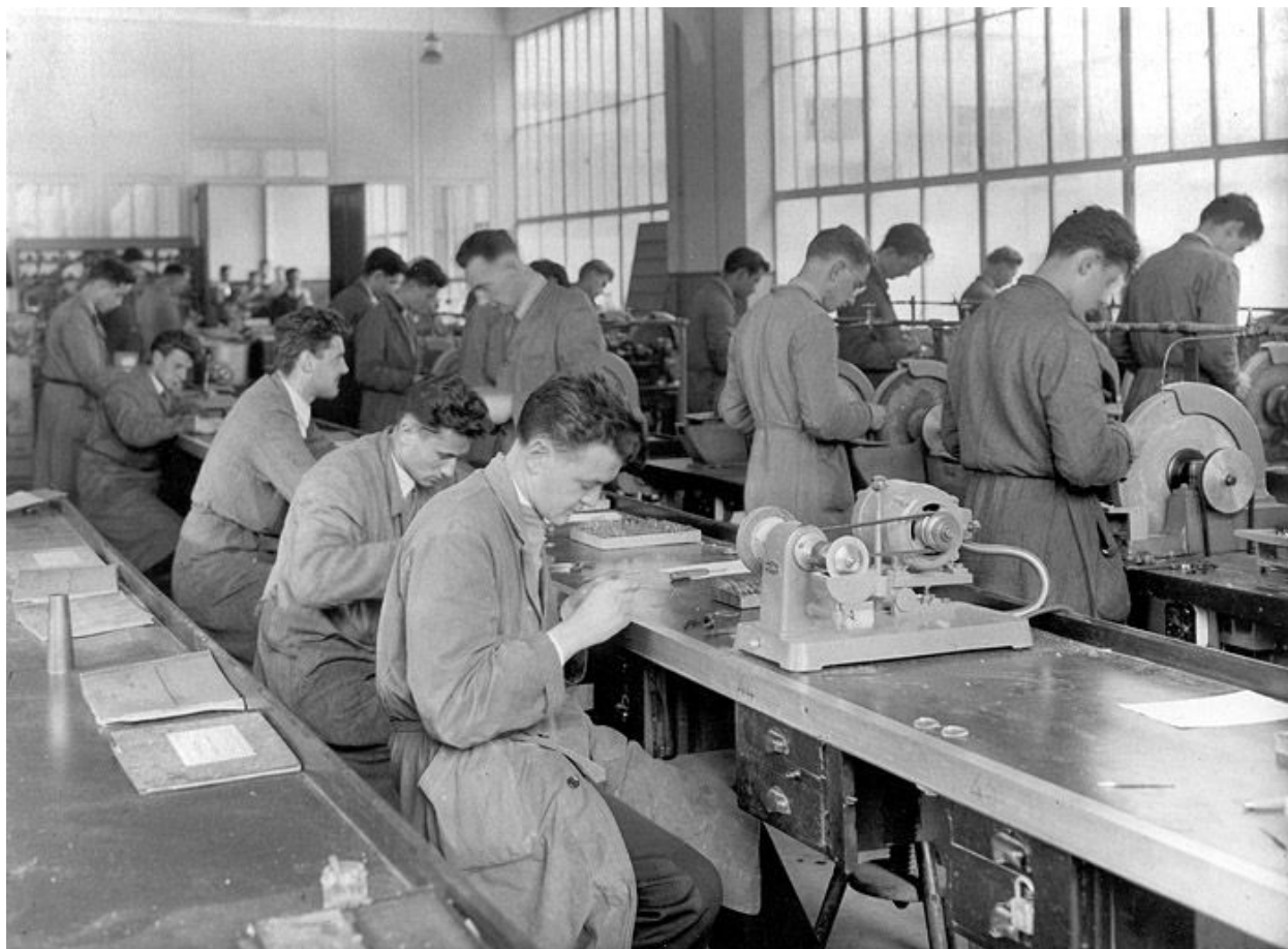
[Le montage des verres], 1955. Meules de finition au premier plan, d'ébauchage au second.
