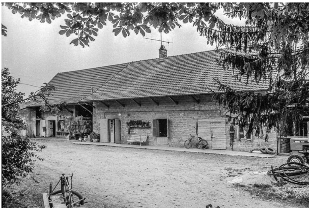
Ferme cadastrée 1969 AD 206-207 : bâtiment agricole.
