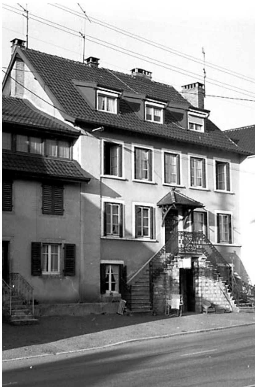
Dasle : maison située rue Centrale.
