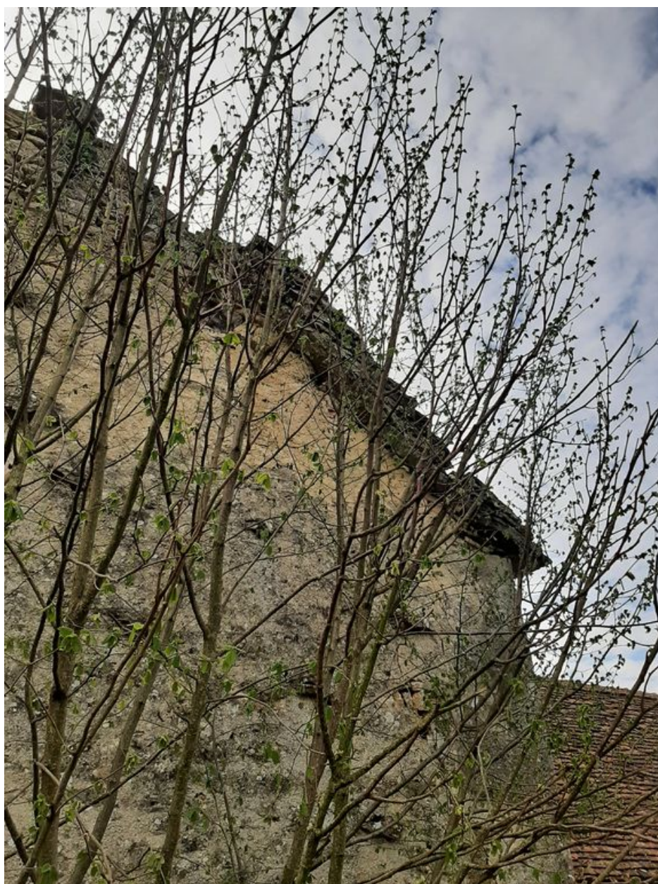
Détail de la rive saillante du toit en laves de la grange.
