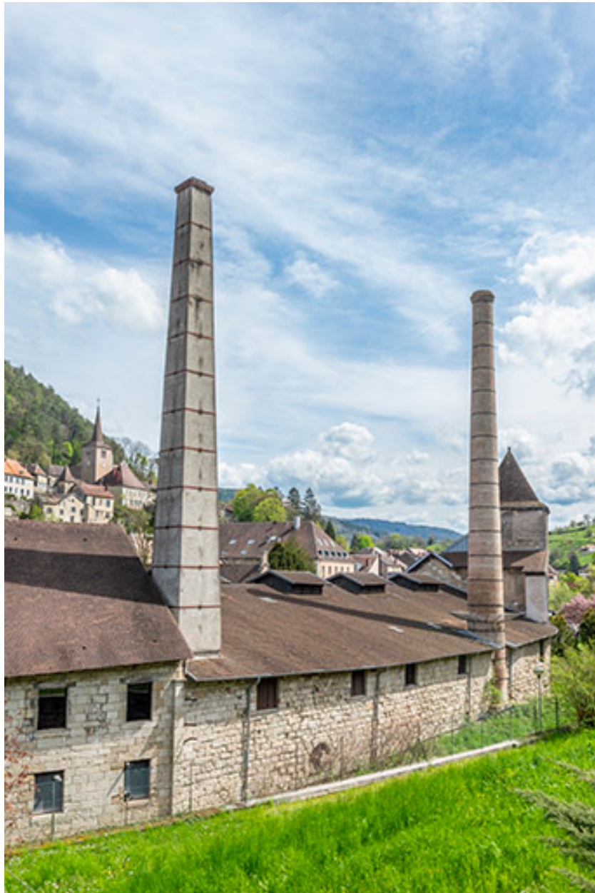
Façade du bâtiment des poêles depuis le nord-ouest.
