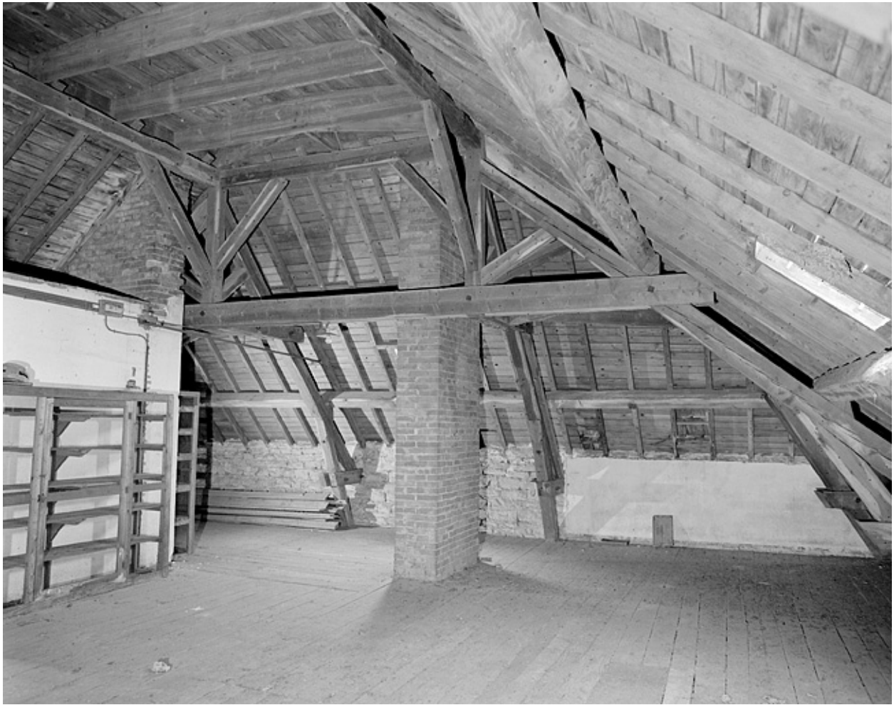
Partie sud : maison du directeur, charpente.
