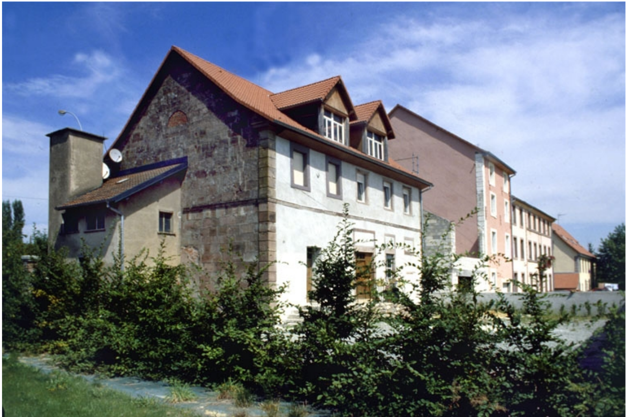
Façade postérieure des ateliers de fabrication.
