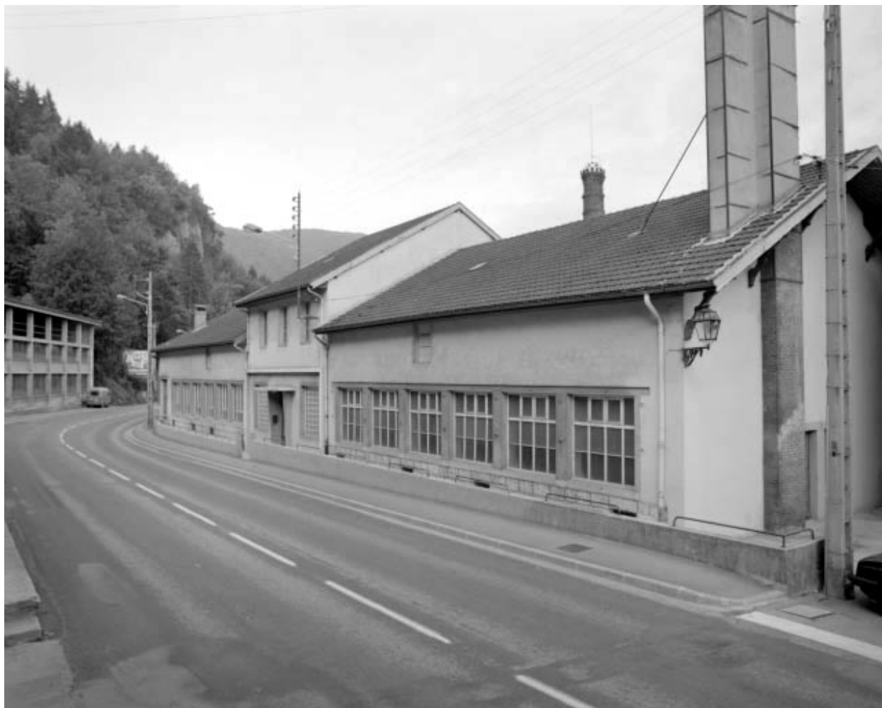
Façade antérieure des ateliers de fabrication.
