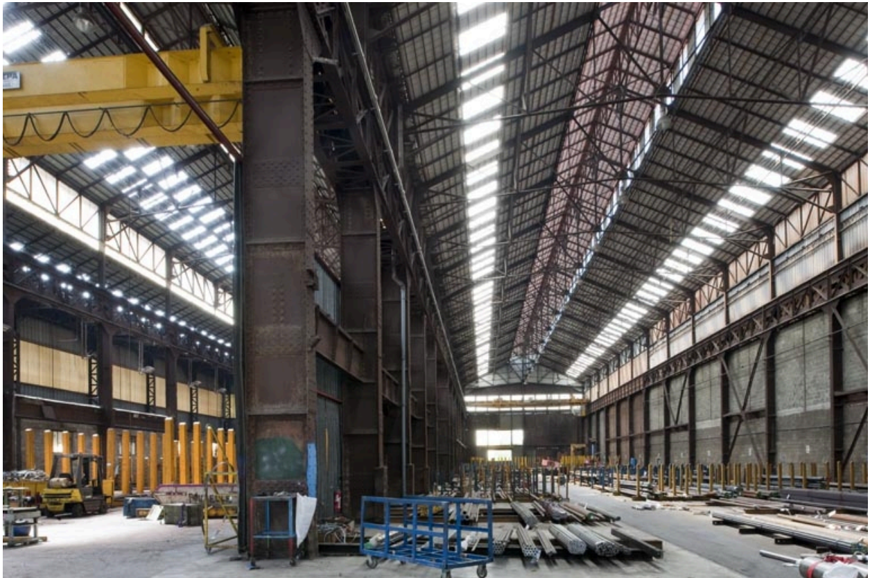
Halles de l'aciérie. Vue intérieure.
