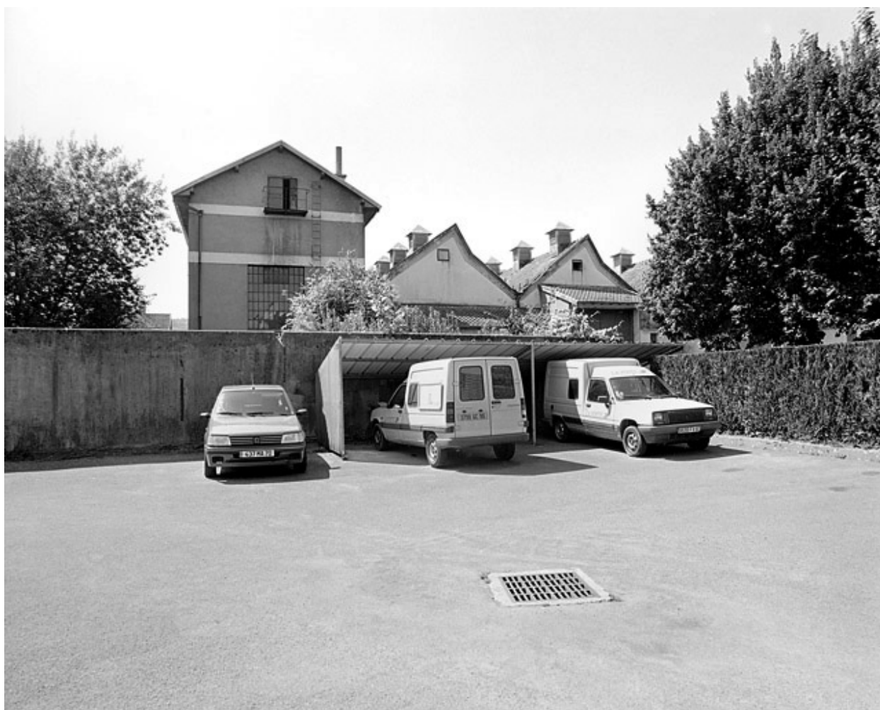
Pignons ouest de la chaufferie et de l'atelier de fabrication.
