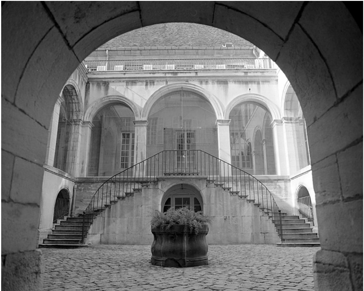
Cour intérieure, escalier : côté ouest.
