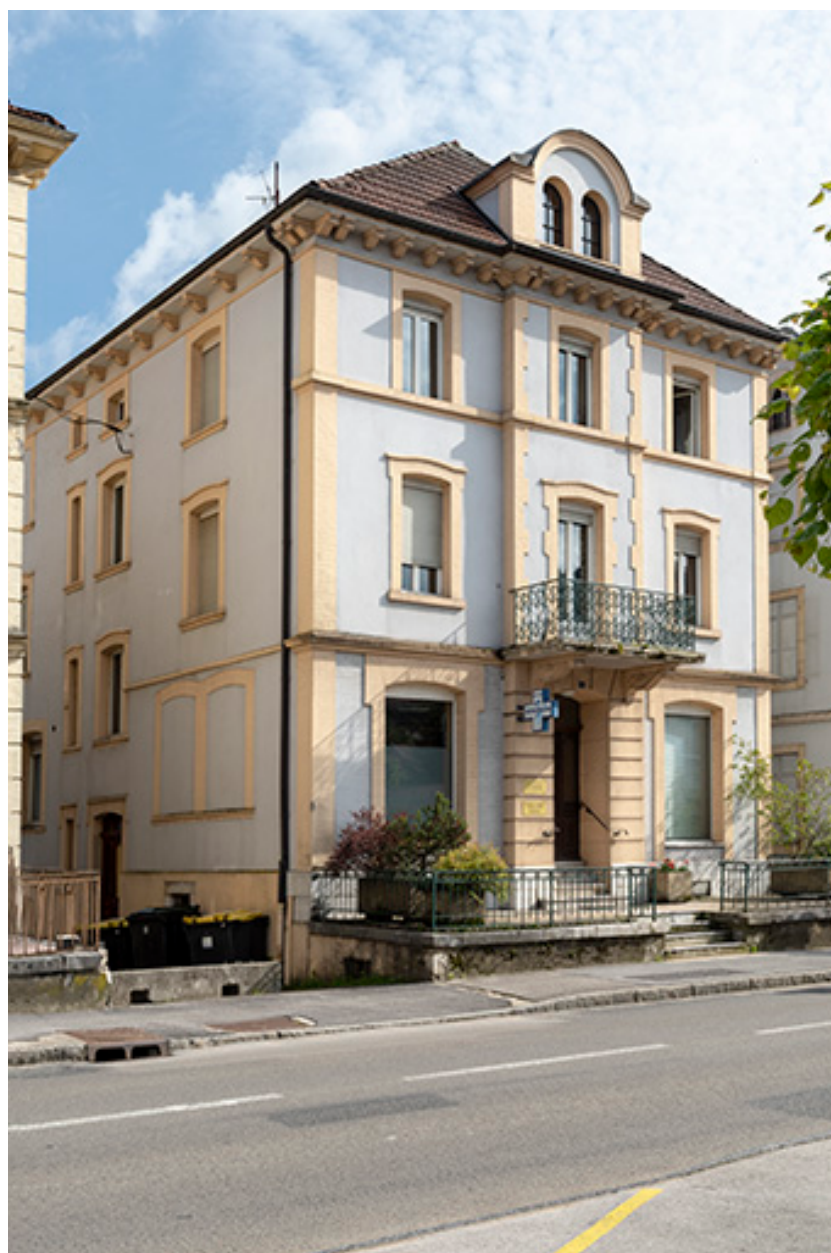
Immeuble et atelier d'horlogerie de Lucien Deleule, 9 rue René Payot.
