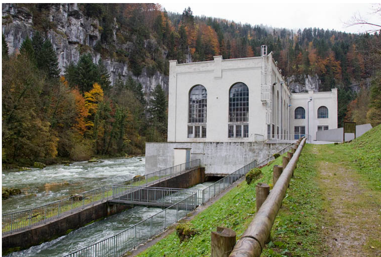
Centrale : façade postérieure (aval).
