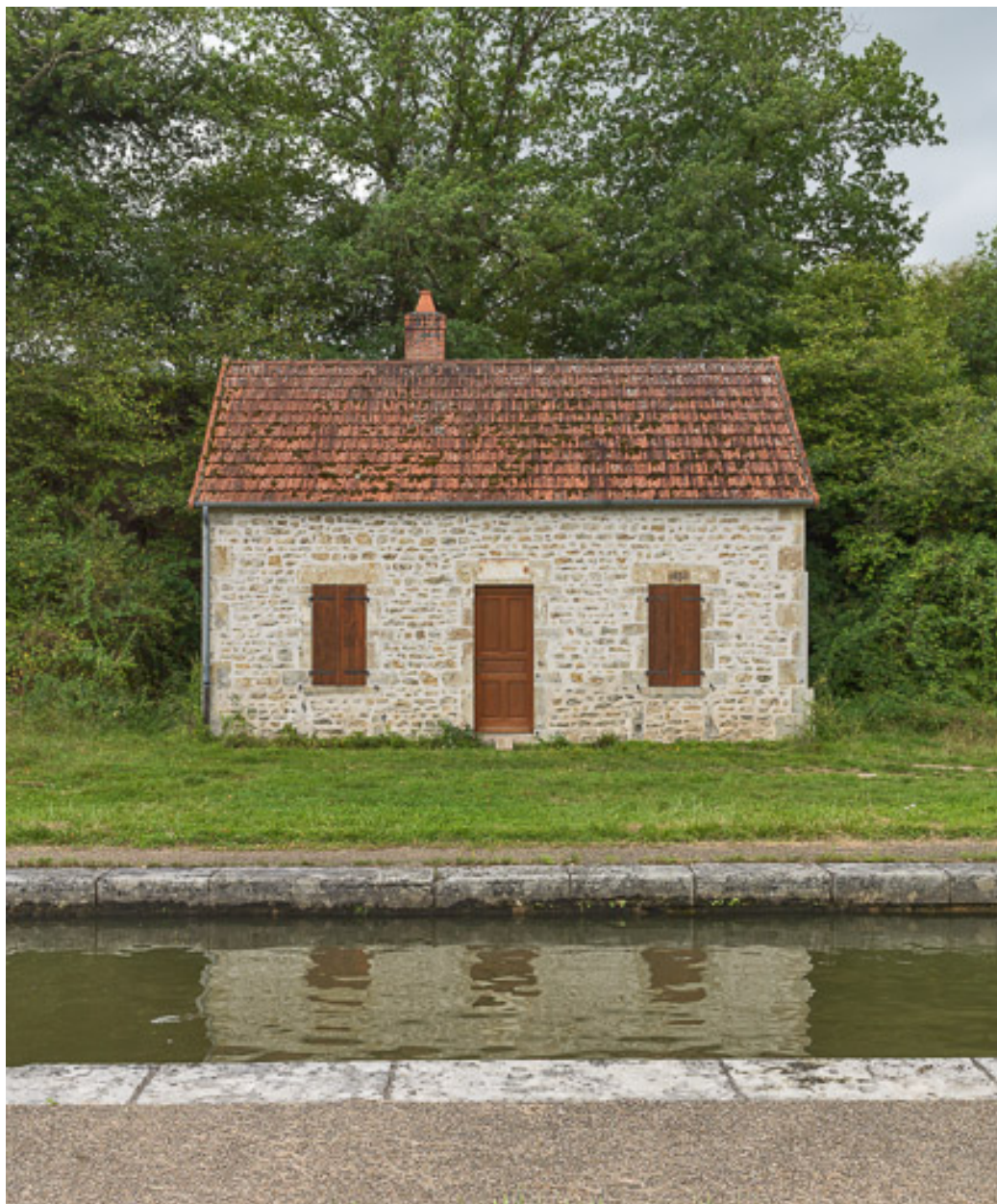
Vue de la maison éclusière.
