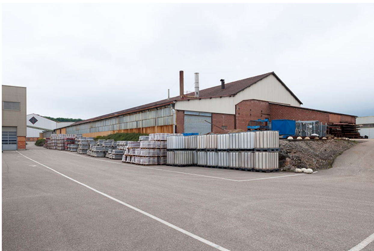
Atelier de fabrication (UL 4).
