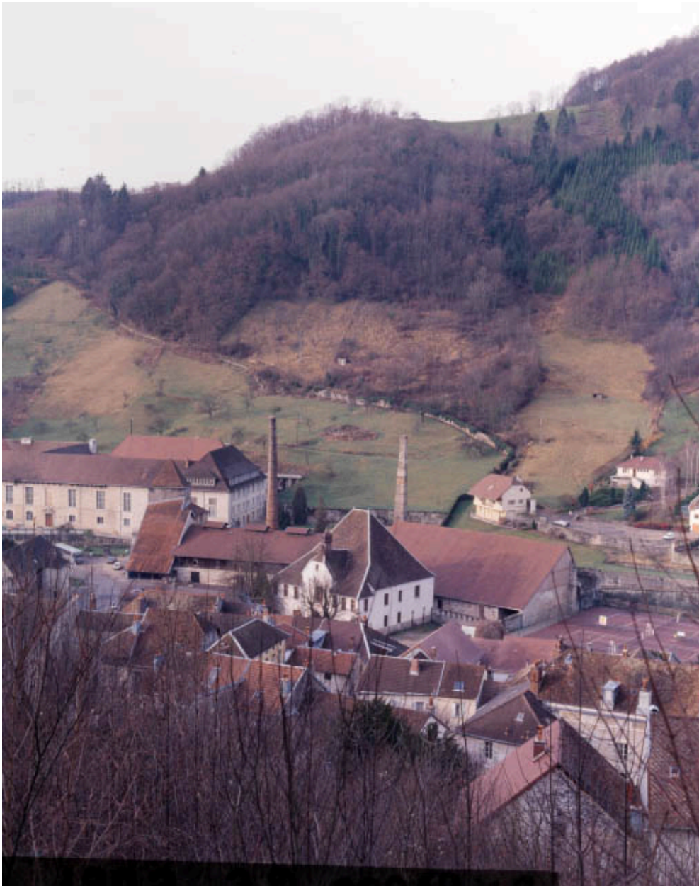
Vue plongeante depuis le nord-est (1993).
