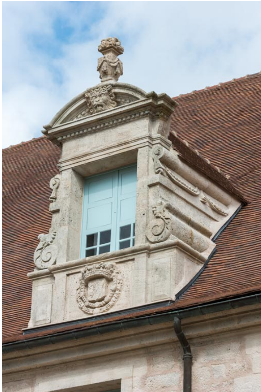
Façade sud-est, lucarne à ailerons à volutes et à fronton cintré surmonté d'un pot-à-feu.
