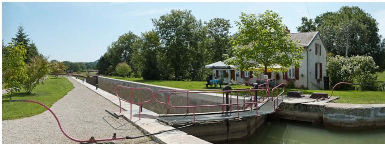
Vue d'ensemble du site d'écluse.
