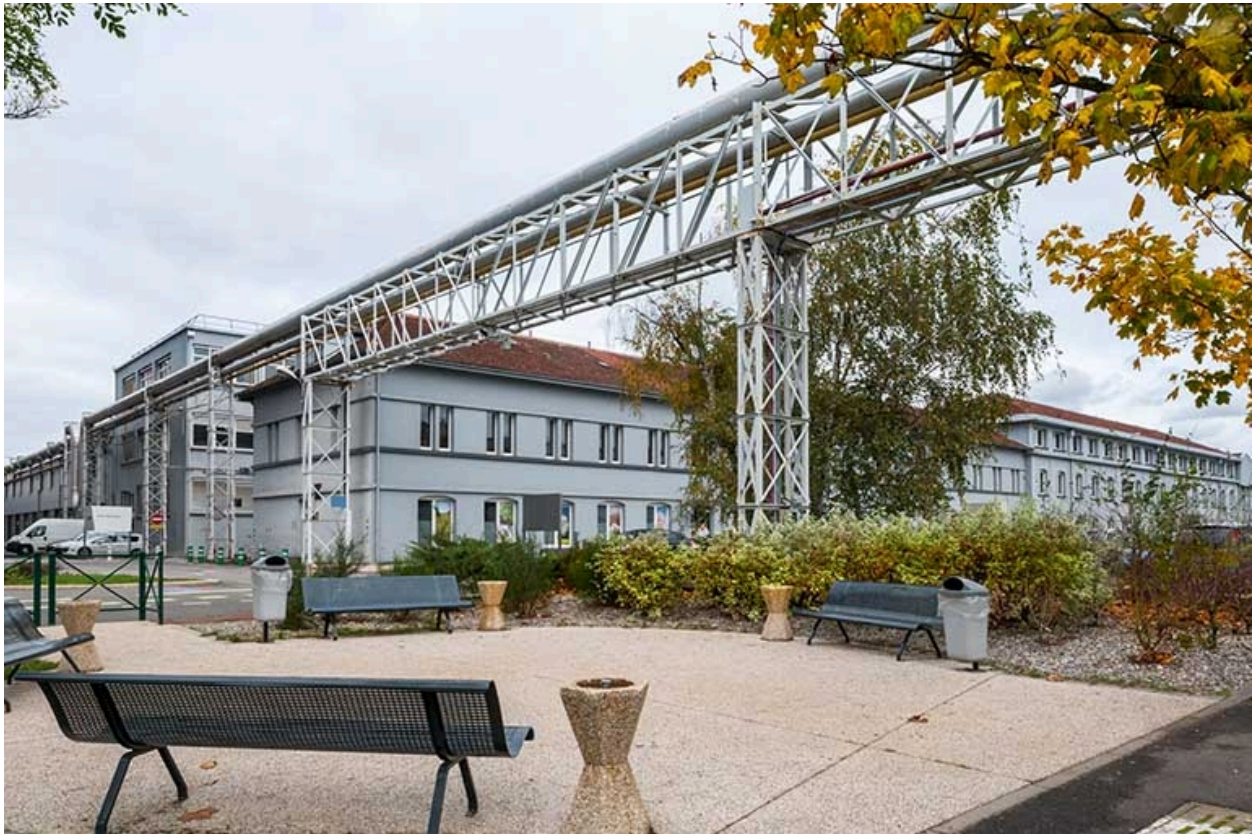
Immeuble dit des Grands bureaux vu de trois quarts gauche.
