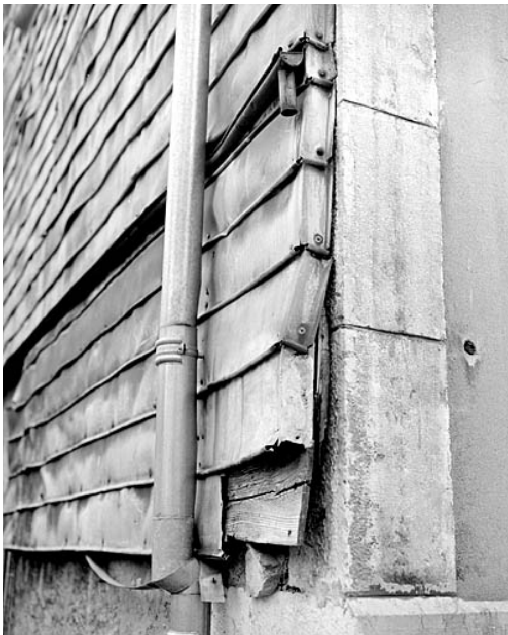
Essentage de tôle sur le mur sud.
