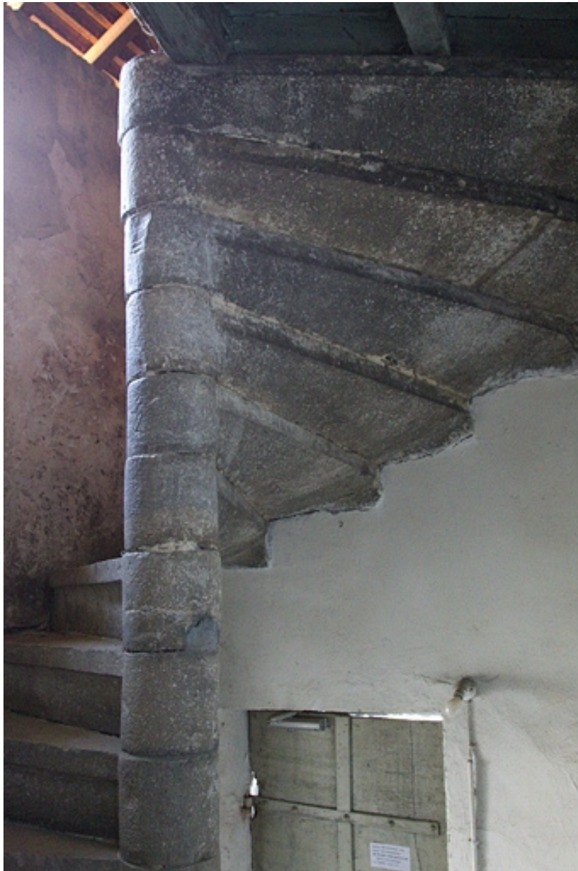
Deuxième logis secondaire : détail d'escalier en vis.
