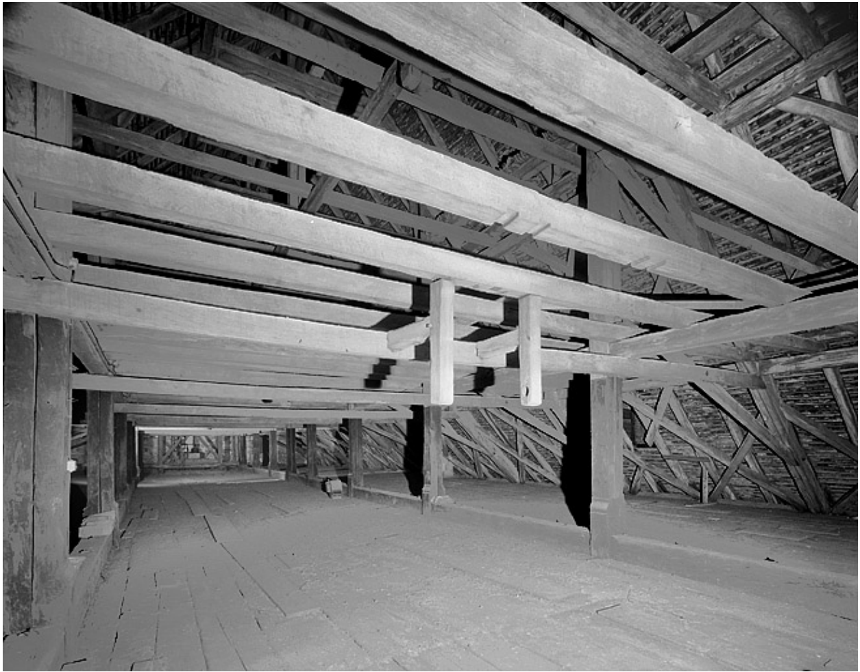
Charpente, vue d'ensemble vers l'est.
