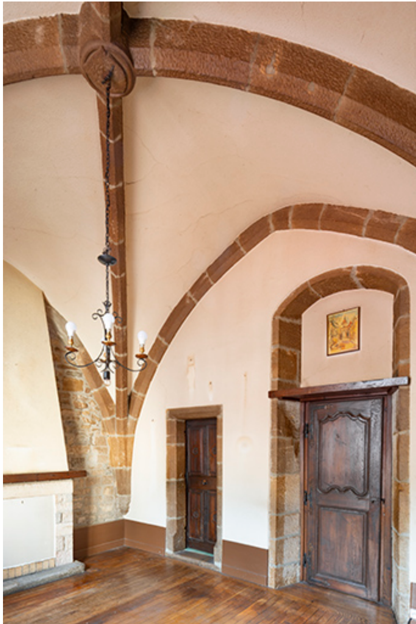
Voûtement de la pièce au premier étage.
