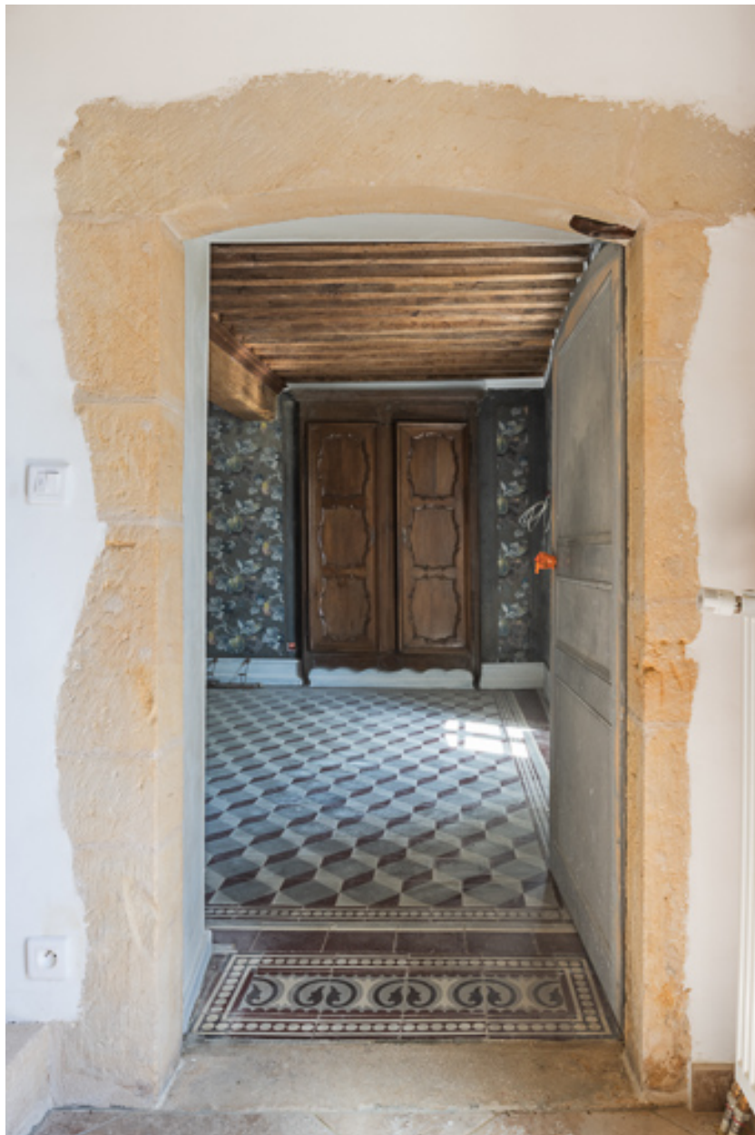
Porte en arc fragmentaire, donnant accès à un salon, à droite de l'escalier de la demeure
