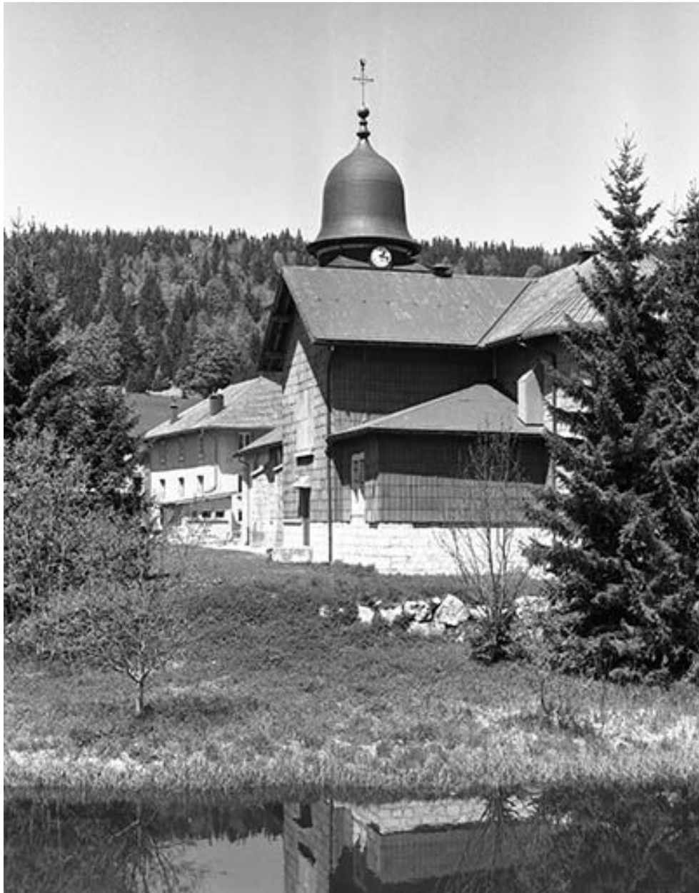
Vue de l'église depuis le sud.
