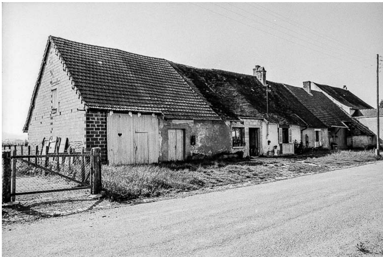
Ferme cadastrée 1984 B2 569-570 : vue d'ensemble.
