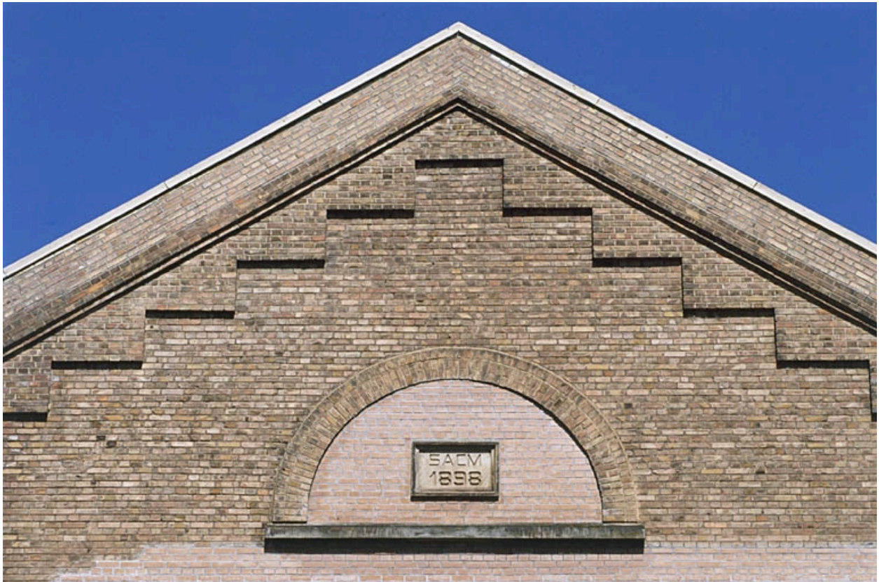
Détail d'un pignon d'un atelier de métallurgie.
