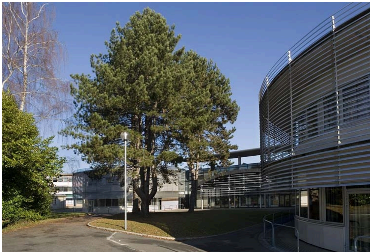
Vue de trois quarts droit bâtiment L.
