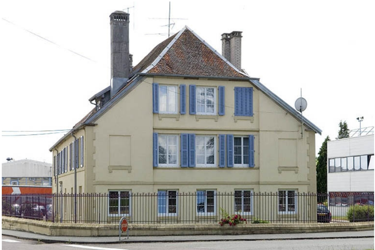
Façade nord du logement patronal.
