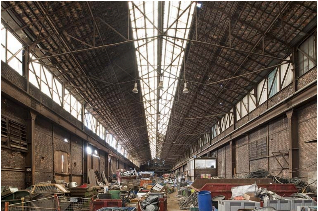
Atelier de laminage. Vue intérieure.
