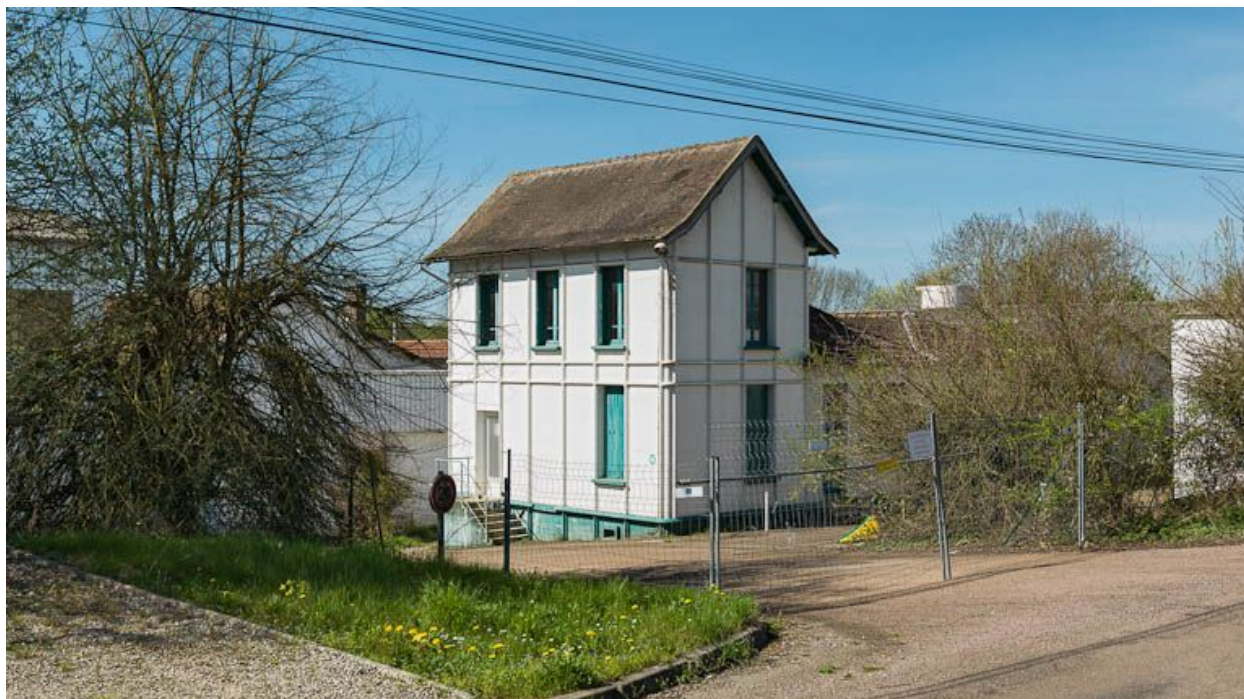
Détail d'un bâtiment de l'entre-deux-guerres.
