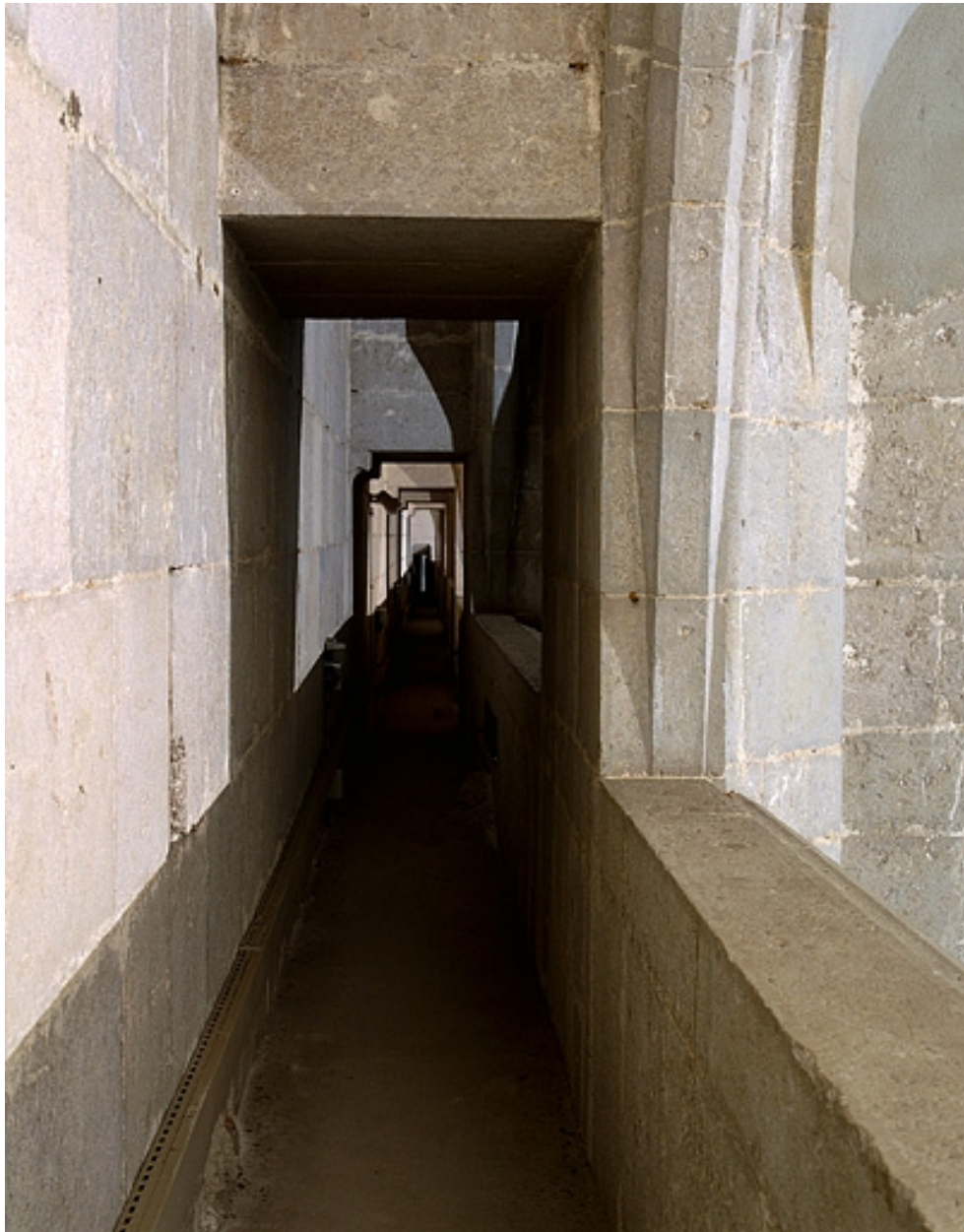
Vue de la coursière haute.
