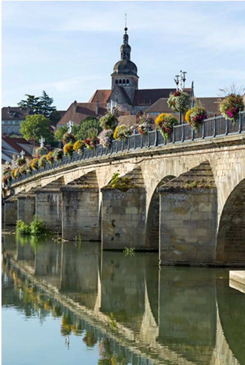
Détail des avant-bec des piles.
