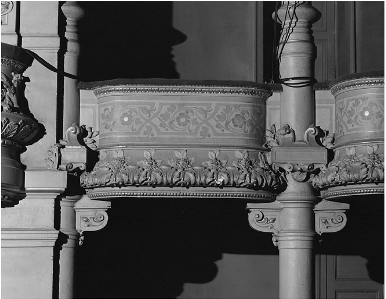
Salle, détail : 1er balcon.
