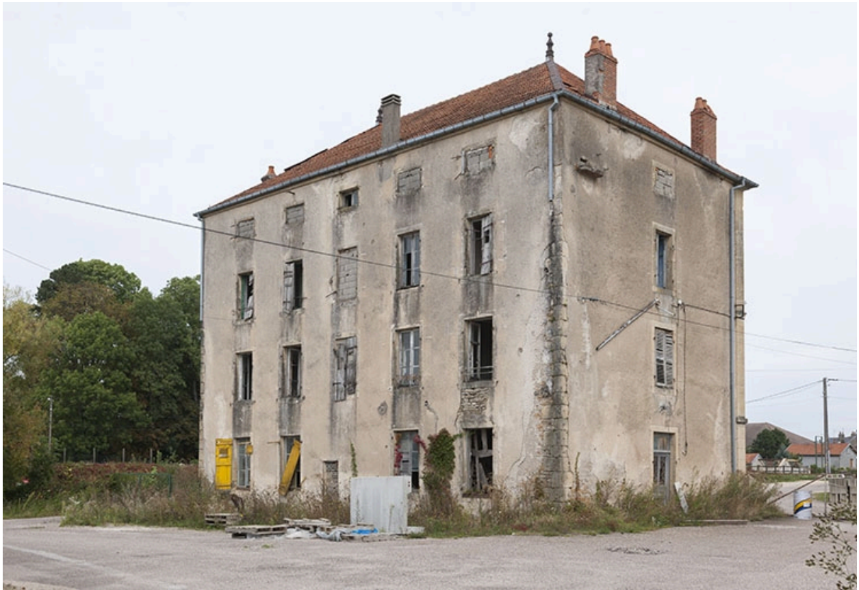
Façade postérieure de trois quart droit.
