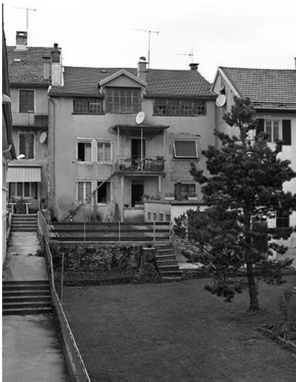
Façade postérieure d'un immeuble.
