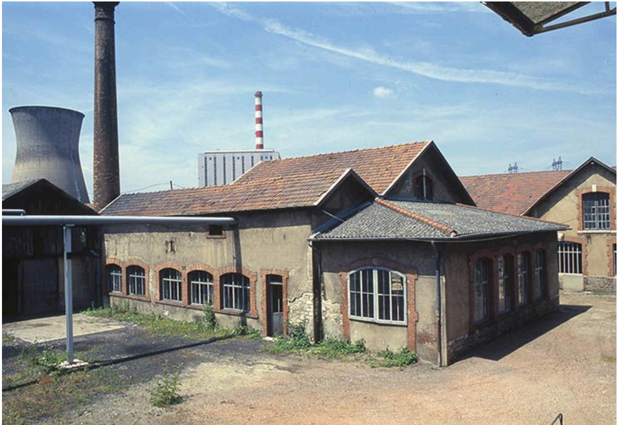
Façade postérieure de l'atelier de montage.
