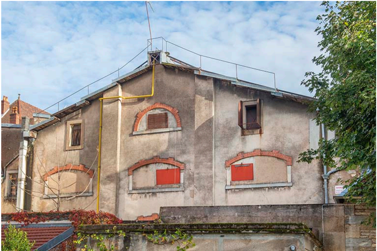
Façade postérieure de la halle (partie haute).
