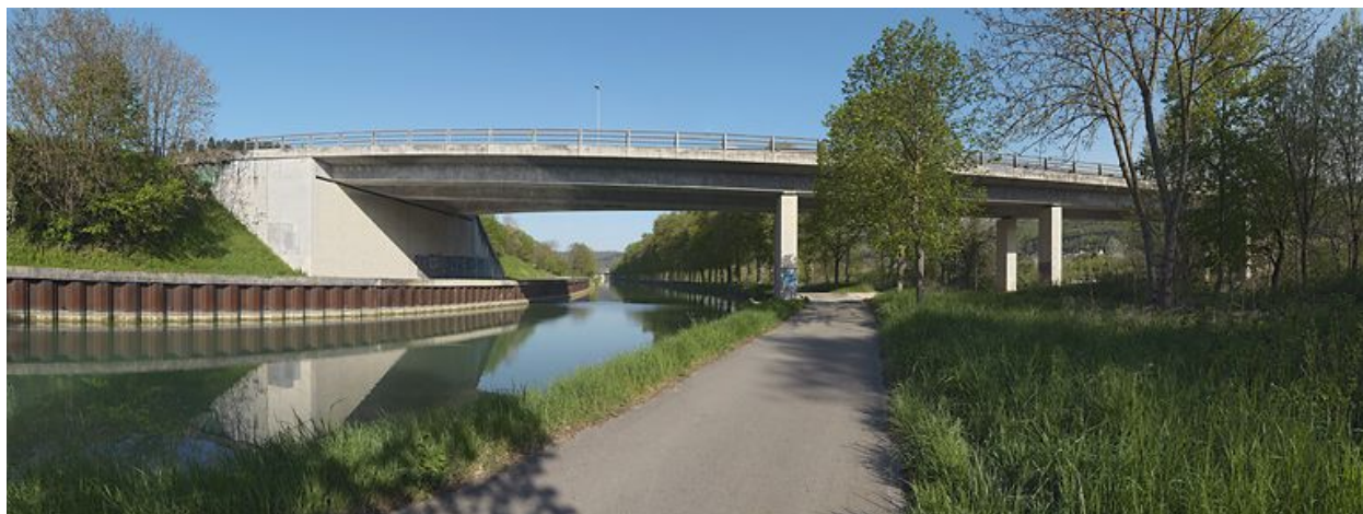
Pont vu d'aval.
