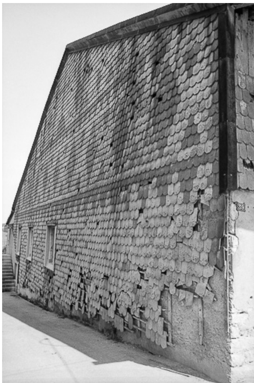
Ferme cadastrée 1962 E 106, 346-347 : façade avec tavaillons.
