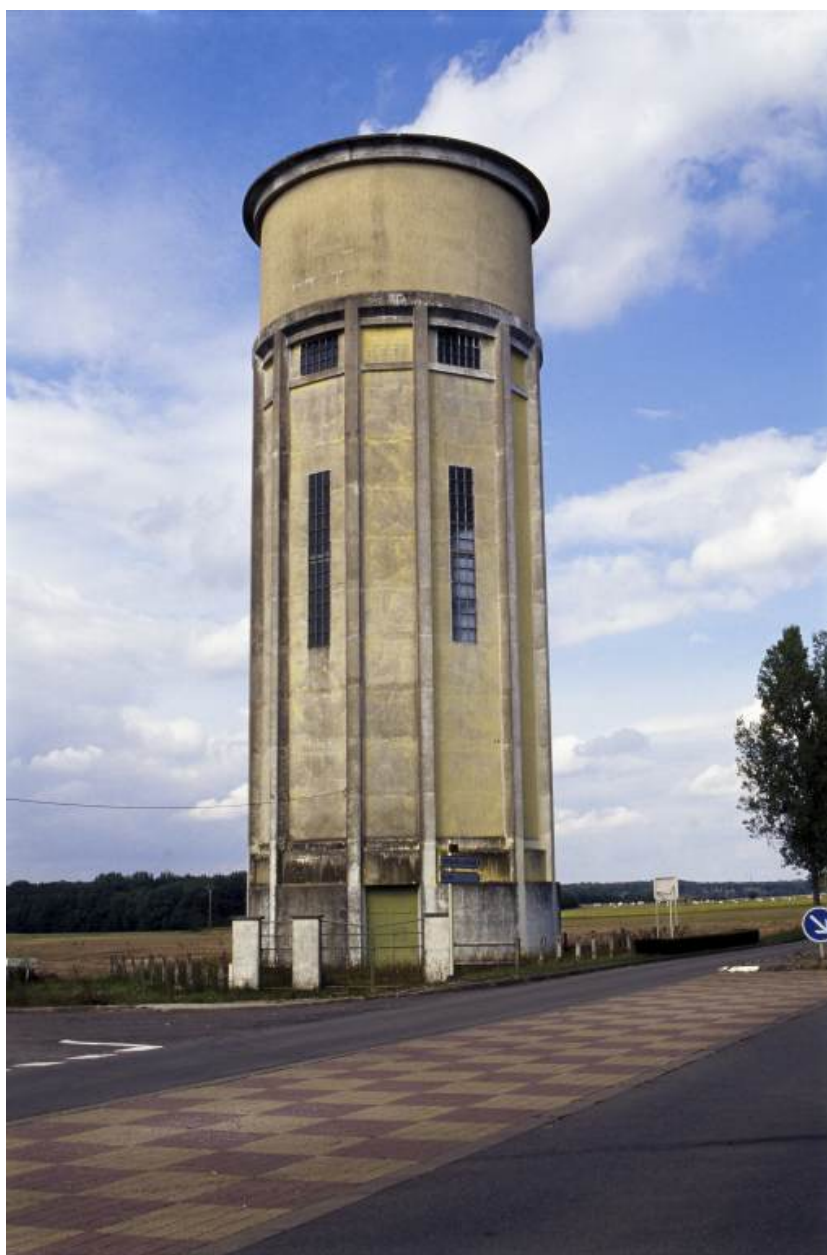
Vue d'ensemble du château d'eau.
