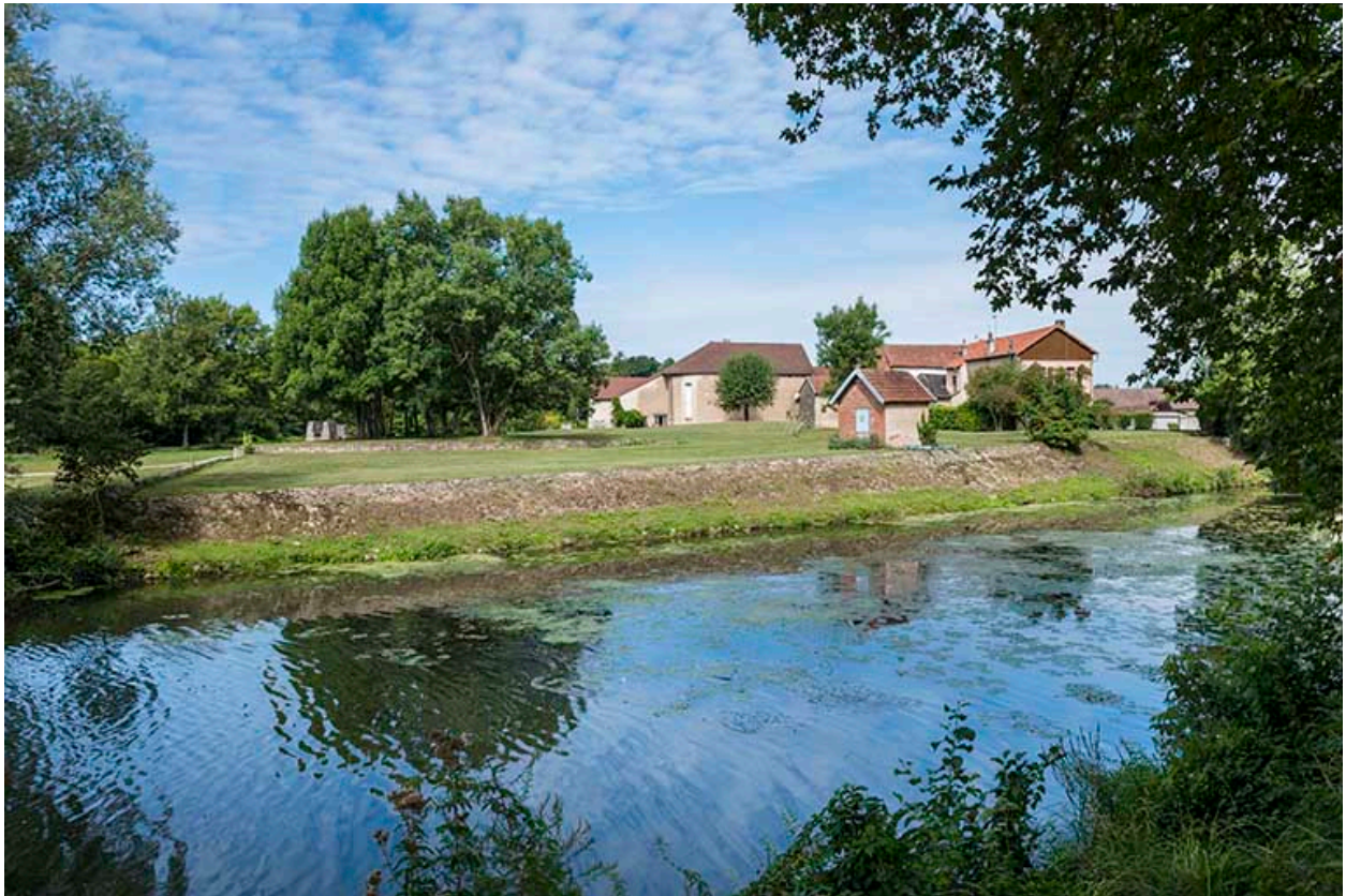
Sud de l'île, vue depuis la digue.
