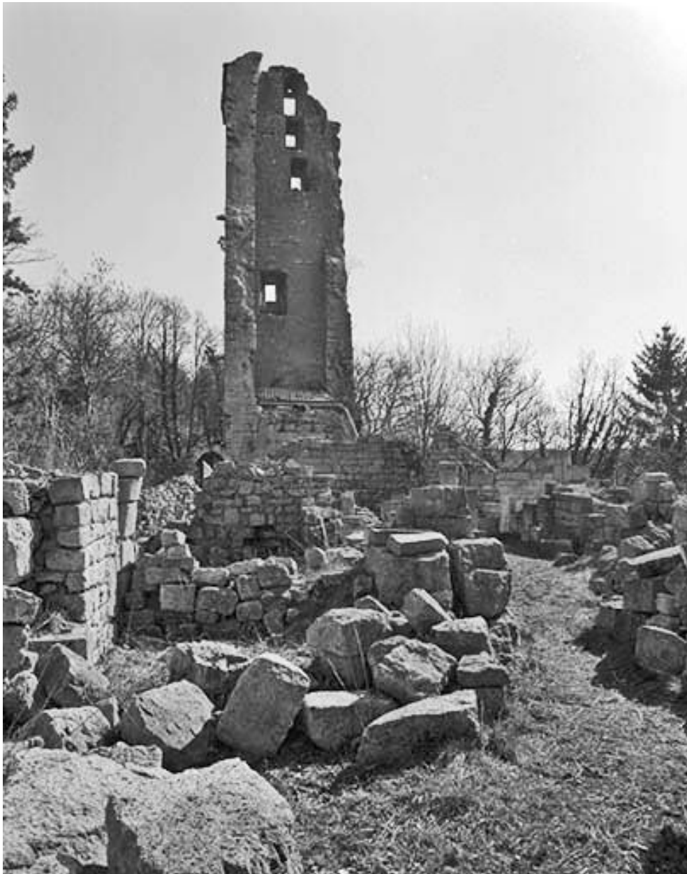
Elévation de la tour Saint-Denis depuis l'ouest.
