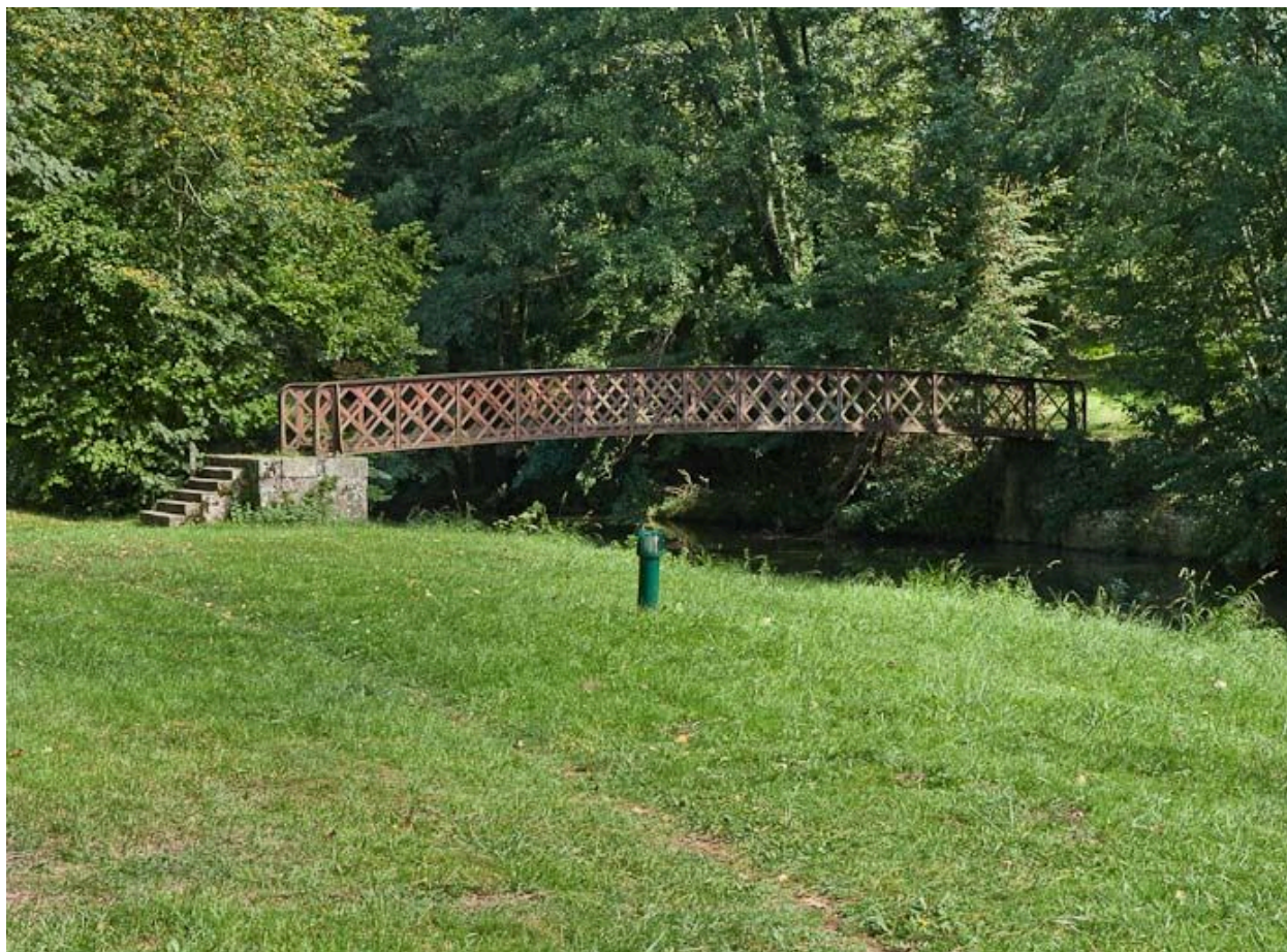
Vue du pont sur rigole.
