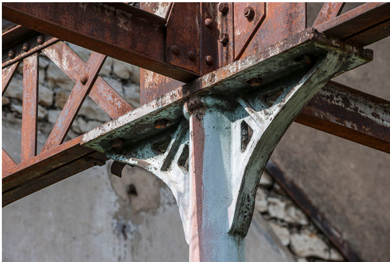
Détail de la charpente métallique.
