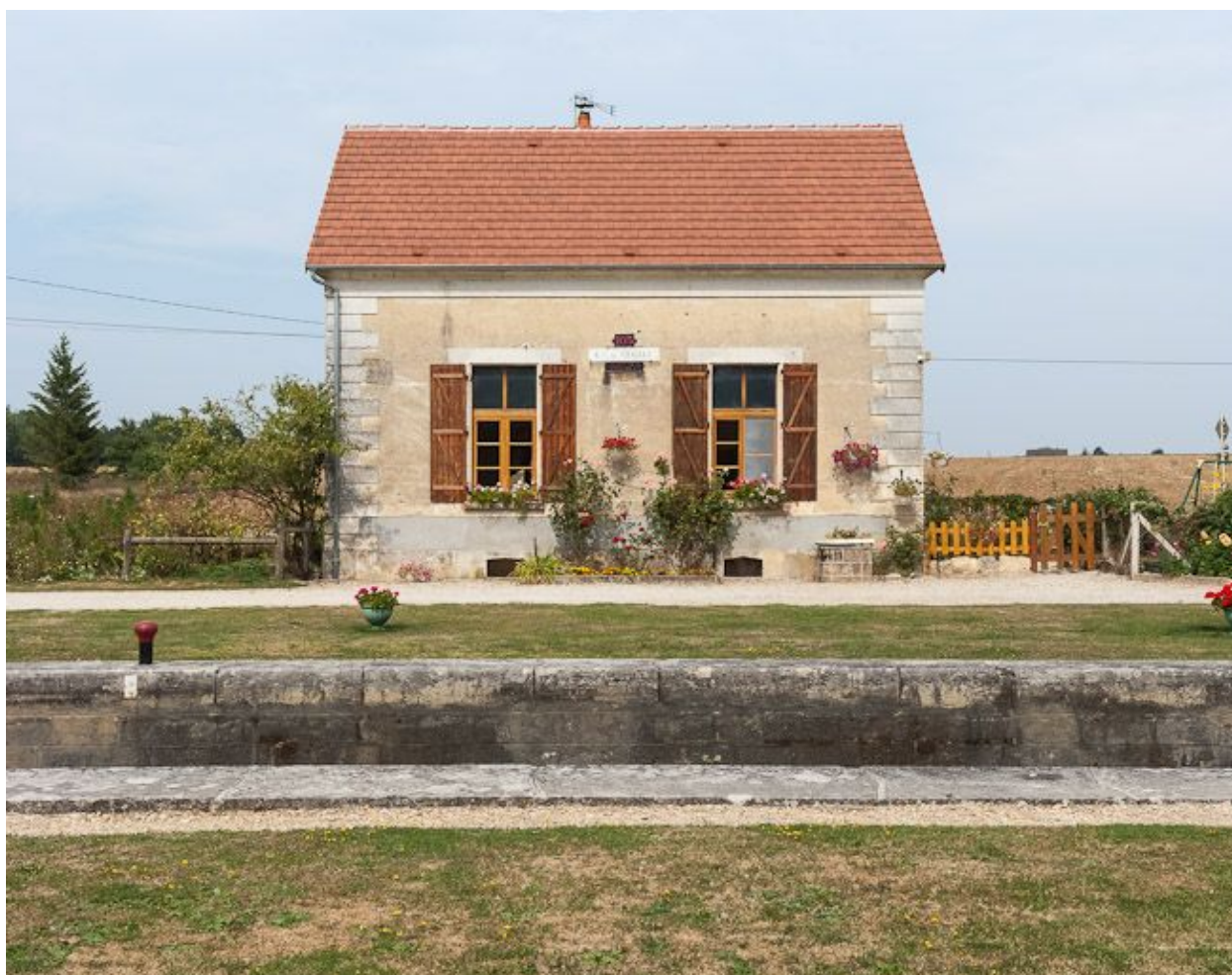
Maison éclusière de face.
