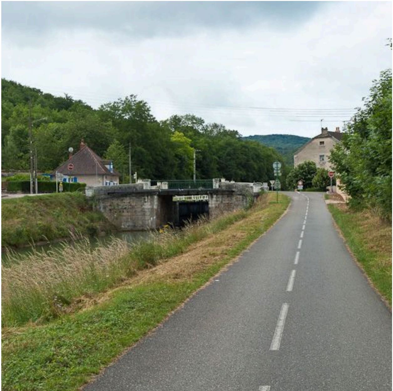
Vue du pont sur écluse depuis l'aval.
