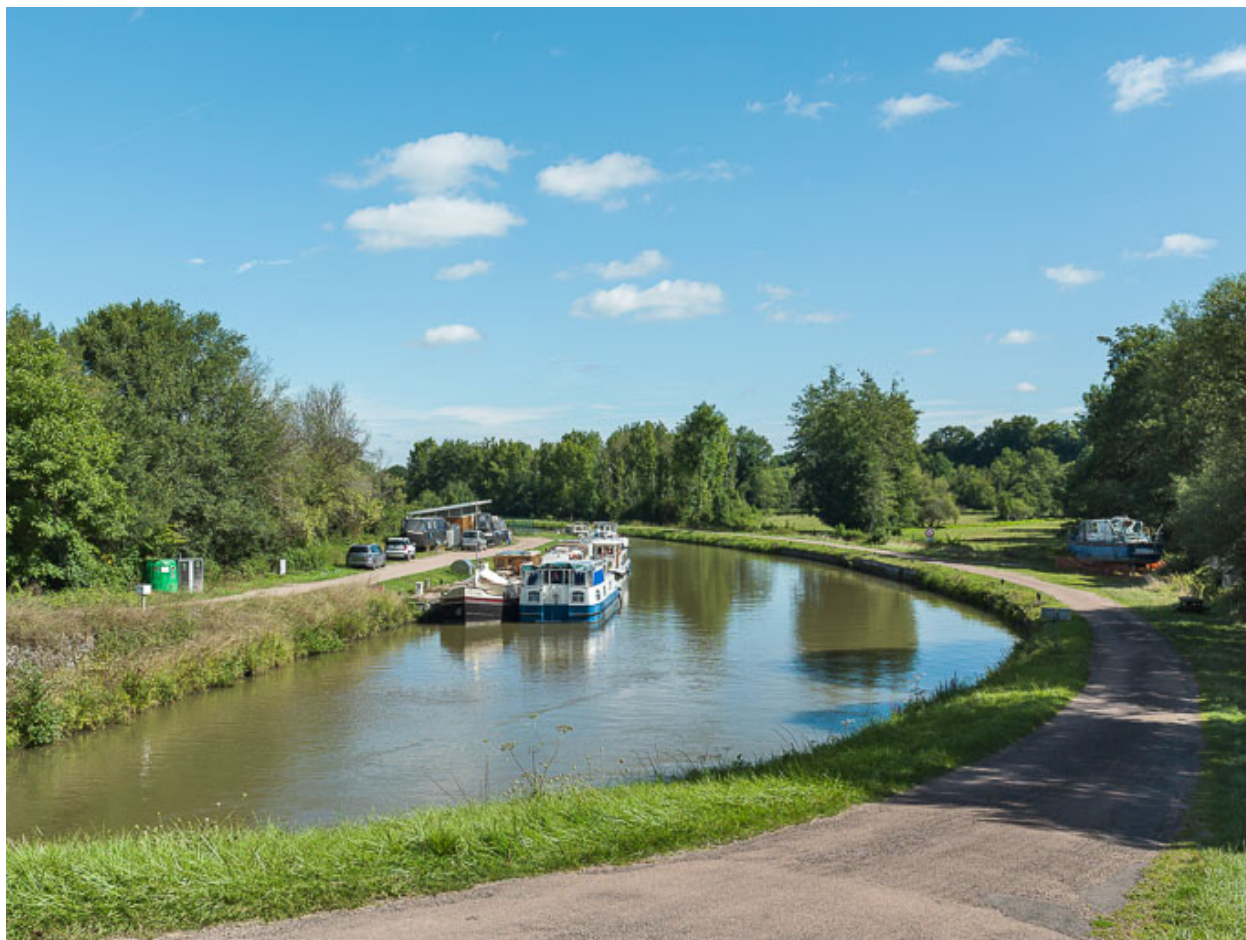
Vue d'ensemble du port.
