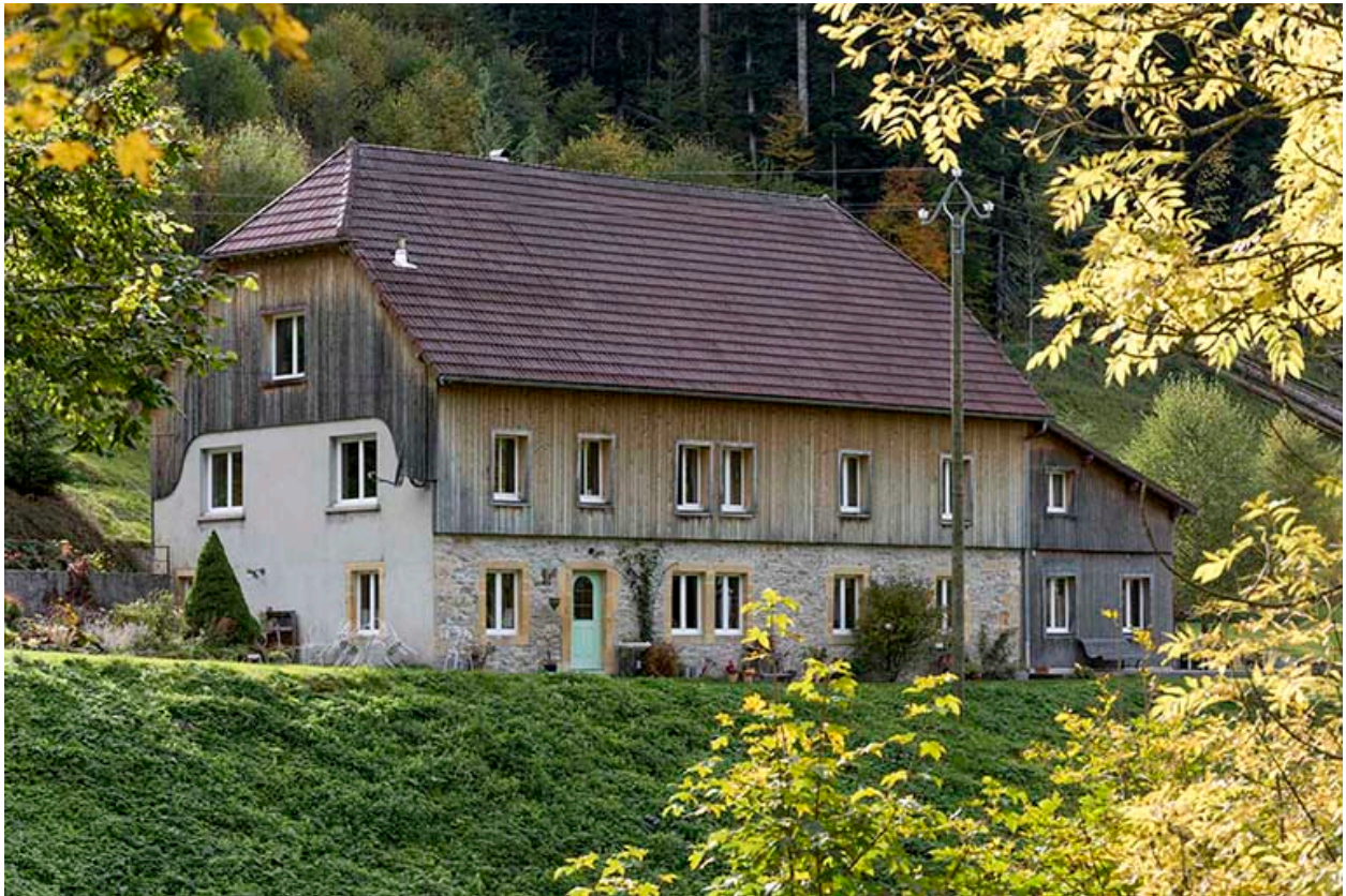
Façades nord et est.
