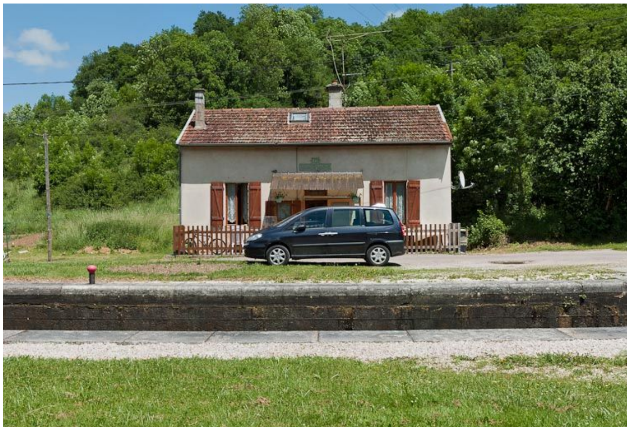
Maison éclésièr vue de face.
